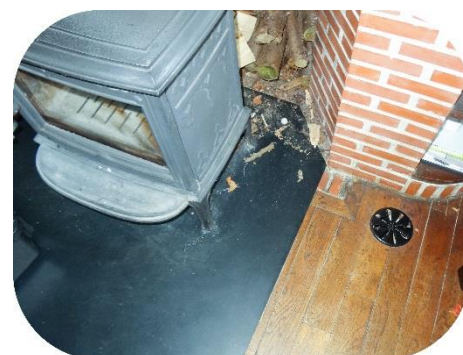
Amenée d'air du poêle au sol 1 er étage, depuis le RDJ
