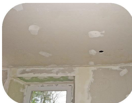
RDJ : placo et vitrages étanches – Trou d'amenée d'air au plafond
